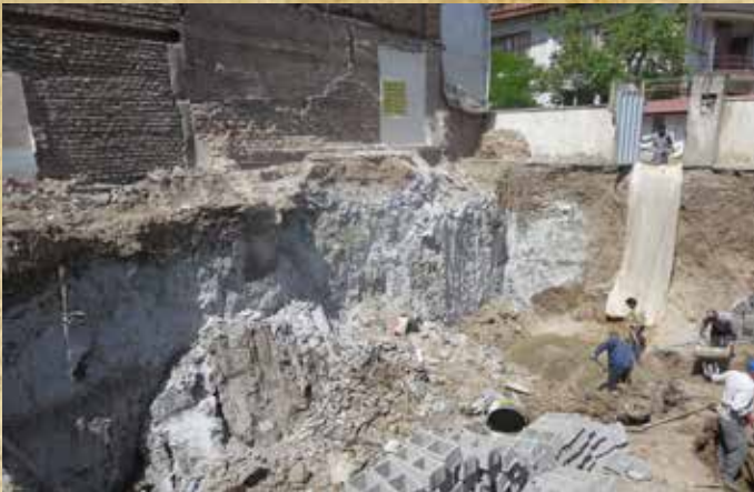
عدم اجرای سازه نگهدارنده و ریزش دیواره گود
