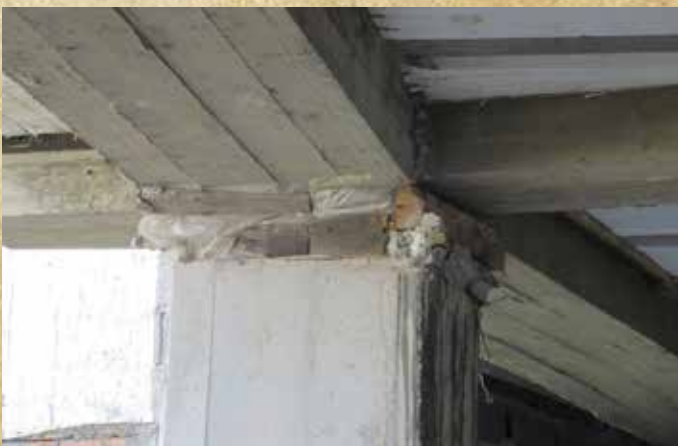
اجرای نامناسب در محل اتصال ستون و تیر
