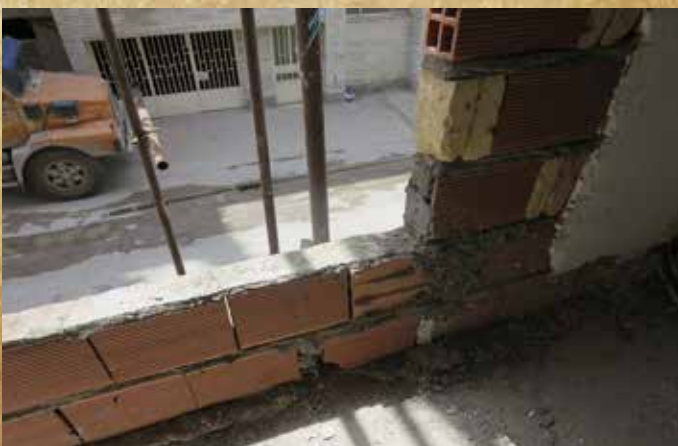
اجرای دیوار خارجی ساختمان به صورت تک جداره
