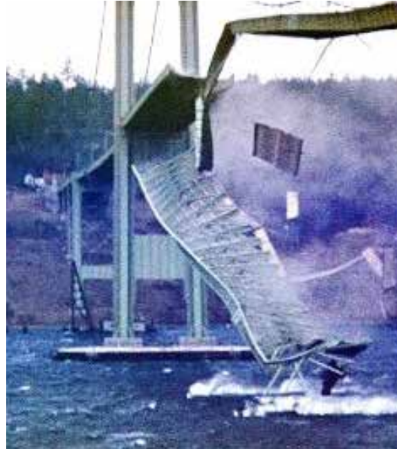
شکل (۲): خرابی زیپی پل تاکوما ناروس آمریکا [۵]
