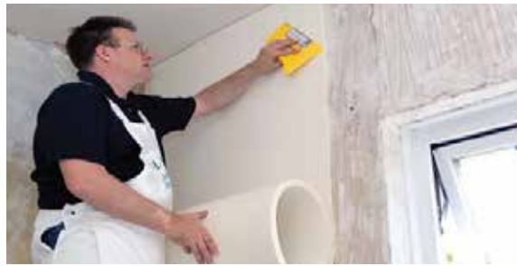
شکل ۴- استفاده از ایروژل پتویی به منظور عایقکاری دیوارها
